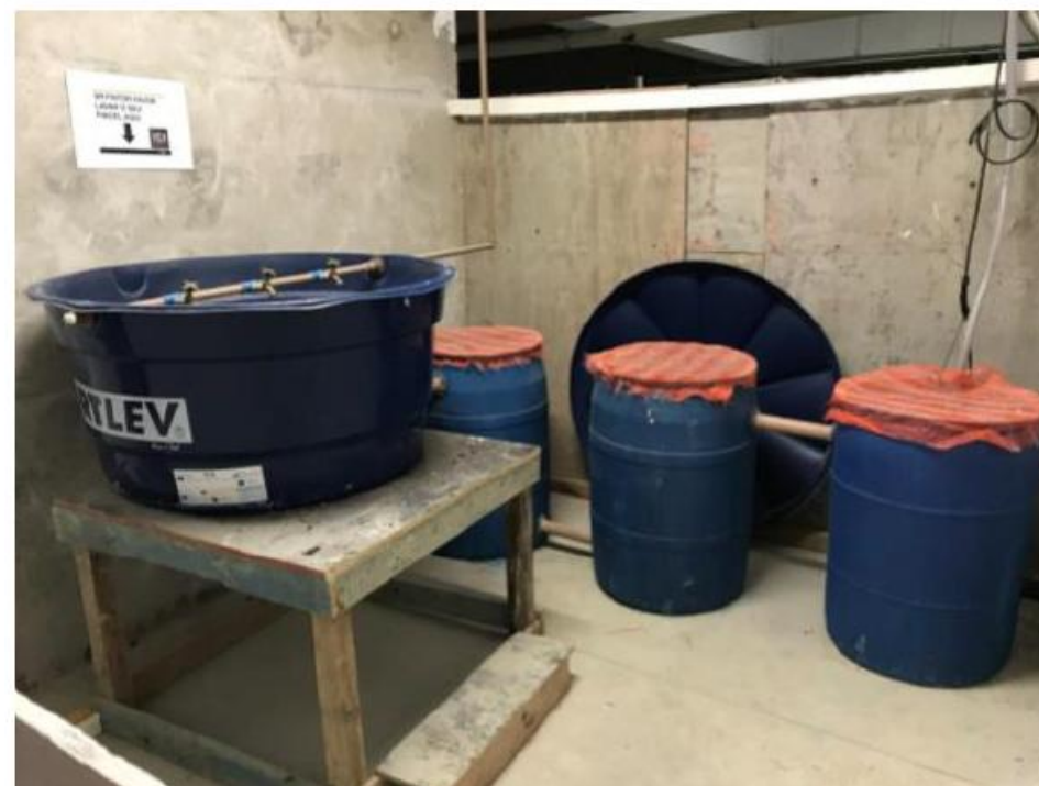
Lava pincéis com sistema de decantação e reaproveitamento
