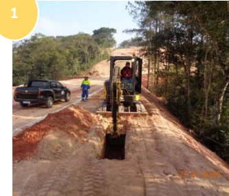
Abertura de Vala Destrutível
