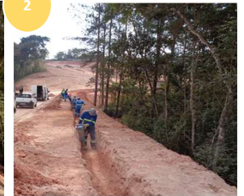
Compactação de Vala
