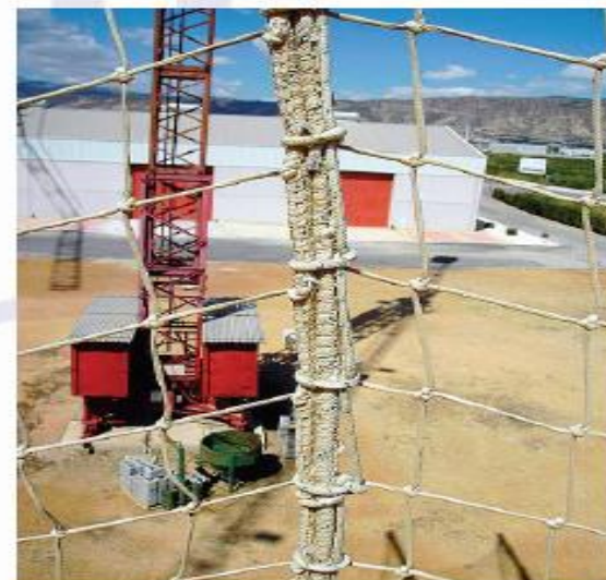
Figura A.4 – Detalhe da união de redes V
