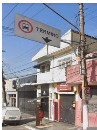
Poste de Iluminação Pública (SPU)
