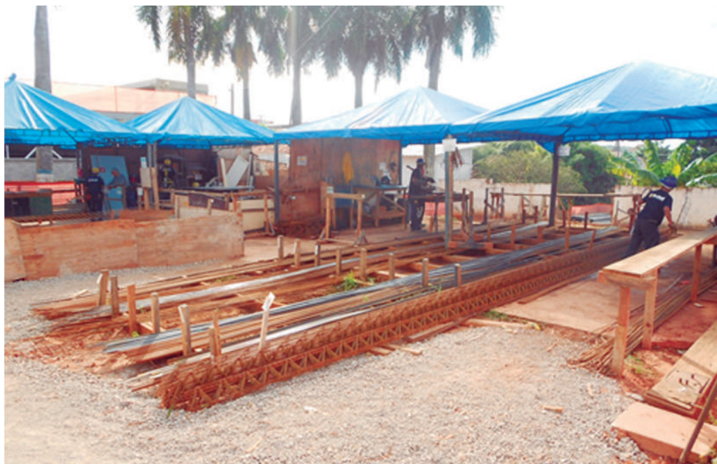
FIGURA 23 FEIXES COM VERGALHÕES E ARMADURAS.
