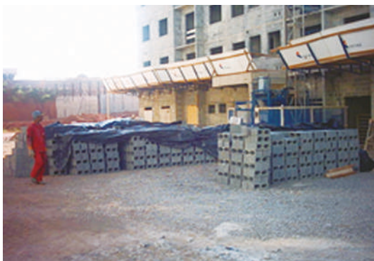
FIGURA 24 EMPILHAMENTO DE BLOCOS EM CONCRETO NO TÉRREO.
