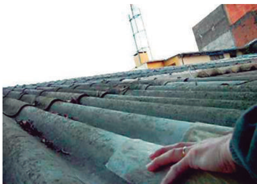
Telhas de cimento amianto
