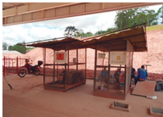
FIGURA 52 ABRIGO PARA RESÍDUOS PERIGOSOS, SEPARADO DO ABRIGO PARA PRODUTOS PERIGOSOS.
