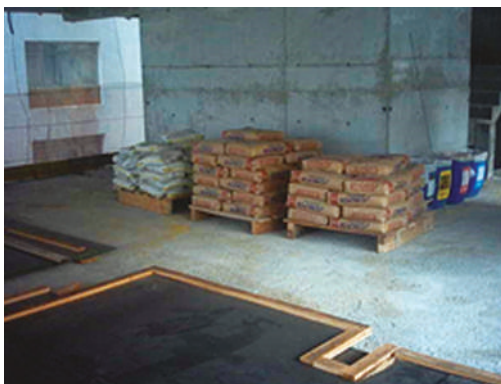
FIGURA 26 SACARIAS DE CIMENTO ESTOCADAS SOBRE PALETES.
