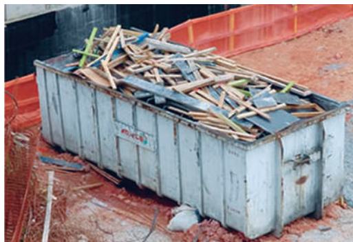
Madeira (fôrmas, pontaletes)
