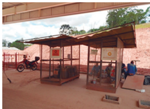
FIGURA 52 ABRIGO PARA RESÍDUOS PERIGOSOS, SEPARADO DO ABRIGO PARA PRODUTOS PERIGOSOS.
