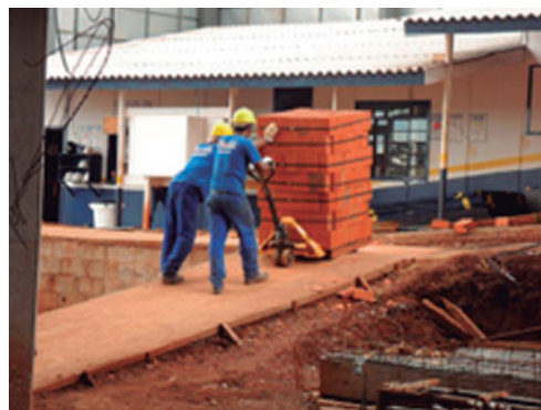
FIGURA 25 USO DE CARRINHO PORTA-PALETES NO TRANSPORTE DE BLOCOS CERÂMICOS.
