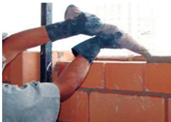
FIGURA 20 USO DE BISNAGA DOSADORA EM ASSENTAMENTO DE BLOCOS PARA VEDAÇÃO.
