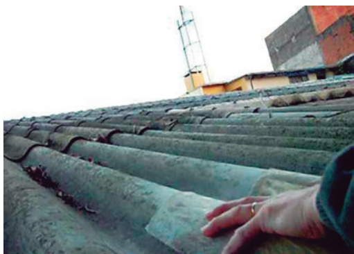
Telhas de cimento amianto
