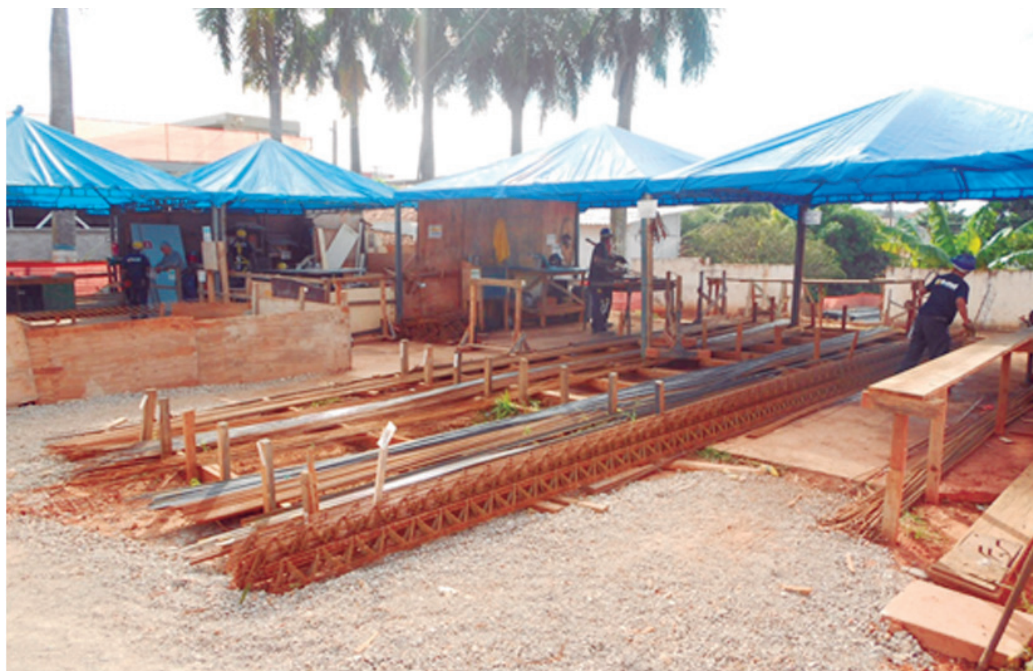
FIGURA 23 FEIXES COM VERGALHÕES E ARMADURAS.
