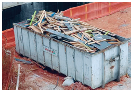
Madeira (fôrmas, pontaletes)
