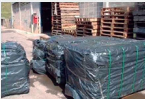
FIGURA 7 BIG BAGS CONTENDO TELHAS DE AMIANTO FRAGMENTADAS
