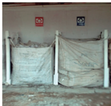
FIGURA 48 BIG BAGS APOIADOS EM SUPORTES PARA ACONDICIONAR RESÍDUOS DE PAPEL E PLÁSTICO EM ÁREA COBERTA.
