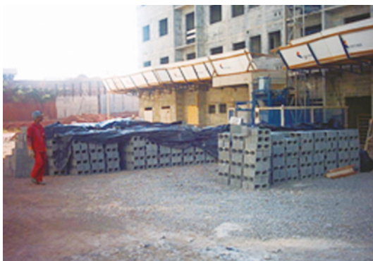
FIGURA 24 EMPILHAMENTO DE BLOCOS EM CONCRETO NO TÉRREO.
