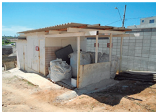
FIGURA 49 BIG BAGS APOIADOS EM SUPORTES PARA ACONDICIONAR RESÍDUOS DE PAPEL E PLÁSTICO EM ÁREA COBERTA.
