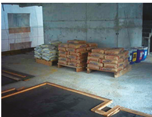
FIGURA 26 SACARIAS DE CIMENTO ESTOCADAS SOBRE PALETES.
