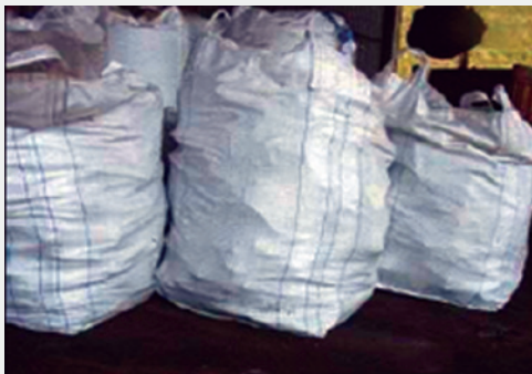
FIGURA 7 BIG BAGS CONTENDO TELHAS DE AMIANTO FRAGMENTADAS
